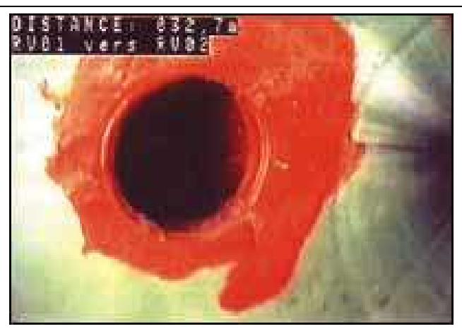
Inspection d'un branchement après intervention
