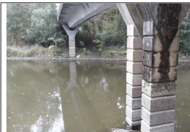
Photo de l'ouvrage (SCE – 2018)
