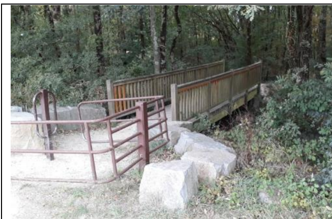
Vue de l'ouvrage (SCE – 2018)
