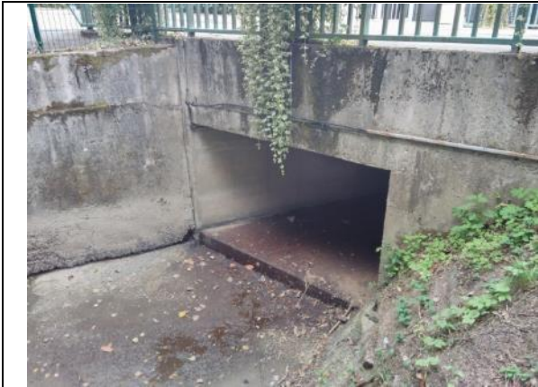
Vue aval de l'ouvrage (SCE – 2018)
