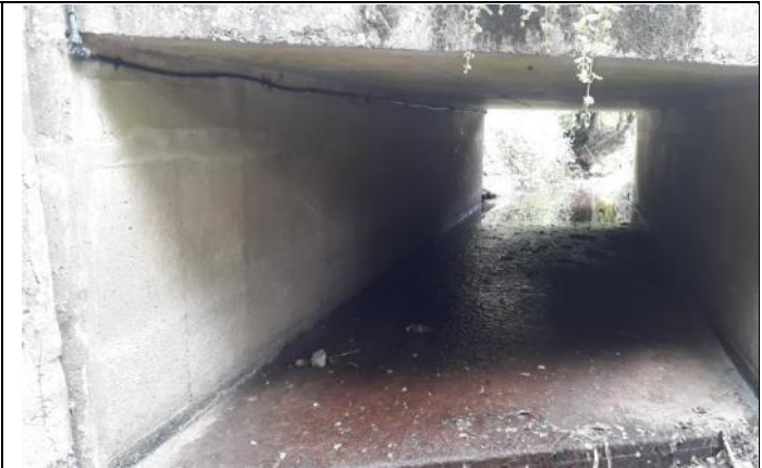
Vue de l'intérieur de l'ouvrage (SCE – 2018)
