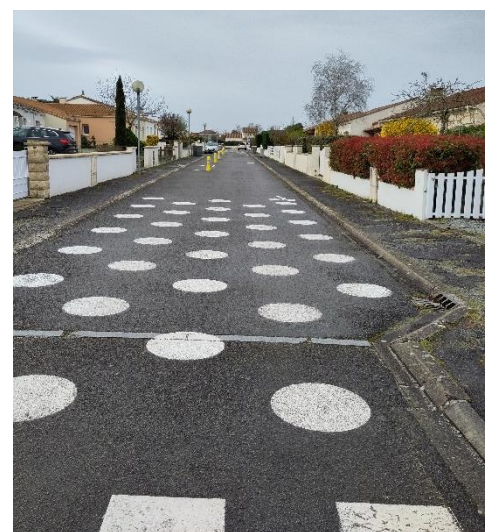
Expérimentation de la chaussée partagée rue des Treilles.
