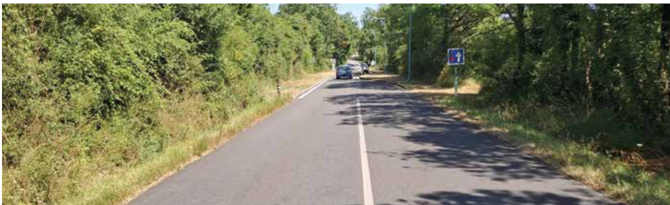
Entrée du bourg vers Viais, pris en charge par la Ville pour garantir une continuité cyclable jusqu'au bourg
