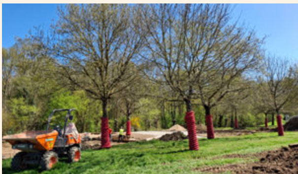
Les travaux se poursuivent pour végétaliser le site et préparer l'arrivée de nouveaux jeux pour enfants
