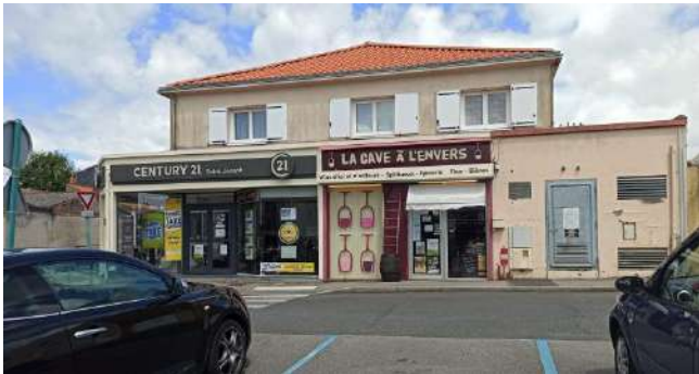
Commerces place Bretagne côté nord
