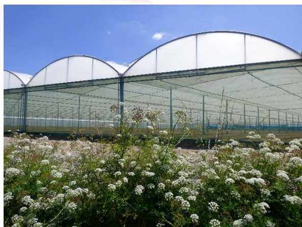
Grands abris pour le maraichage (La Vincée)
