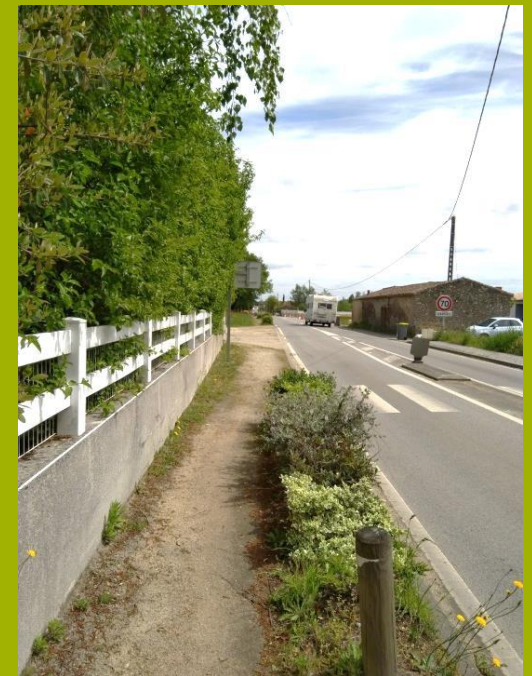
Aménagement de bas-côté : rue du Pays de Retz (RD11)
